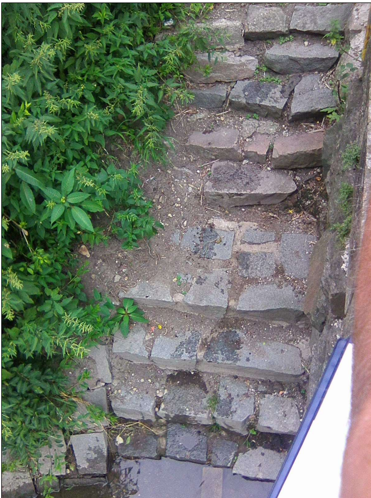
Obr. 6: Poškozené PB schodiště, foto 7/2022
