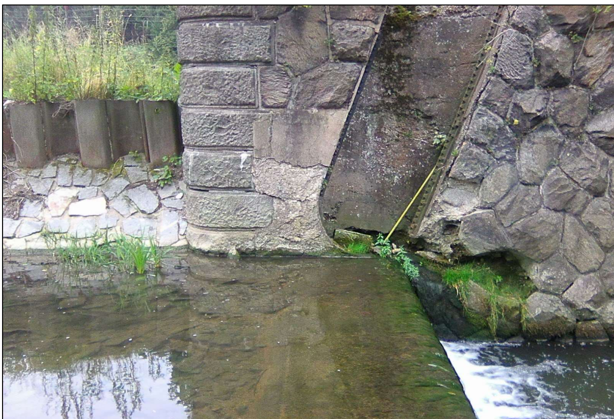
Obr. 5: Detail poškození LB pilíře (7/2022)
